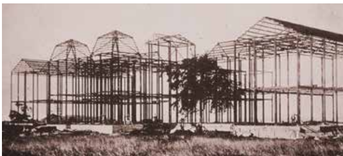
El 6 de julio de 1909 dio comienzo la construcción del nuevo Sanatorio. En la imagen, estado de las obras el 30 de septiembre de 1909.
