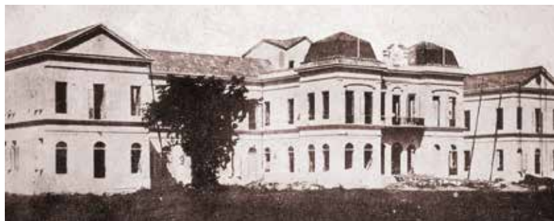
El Sanatorio Auxilio Mutuo en construcción. (Año 1910)
